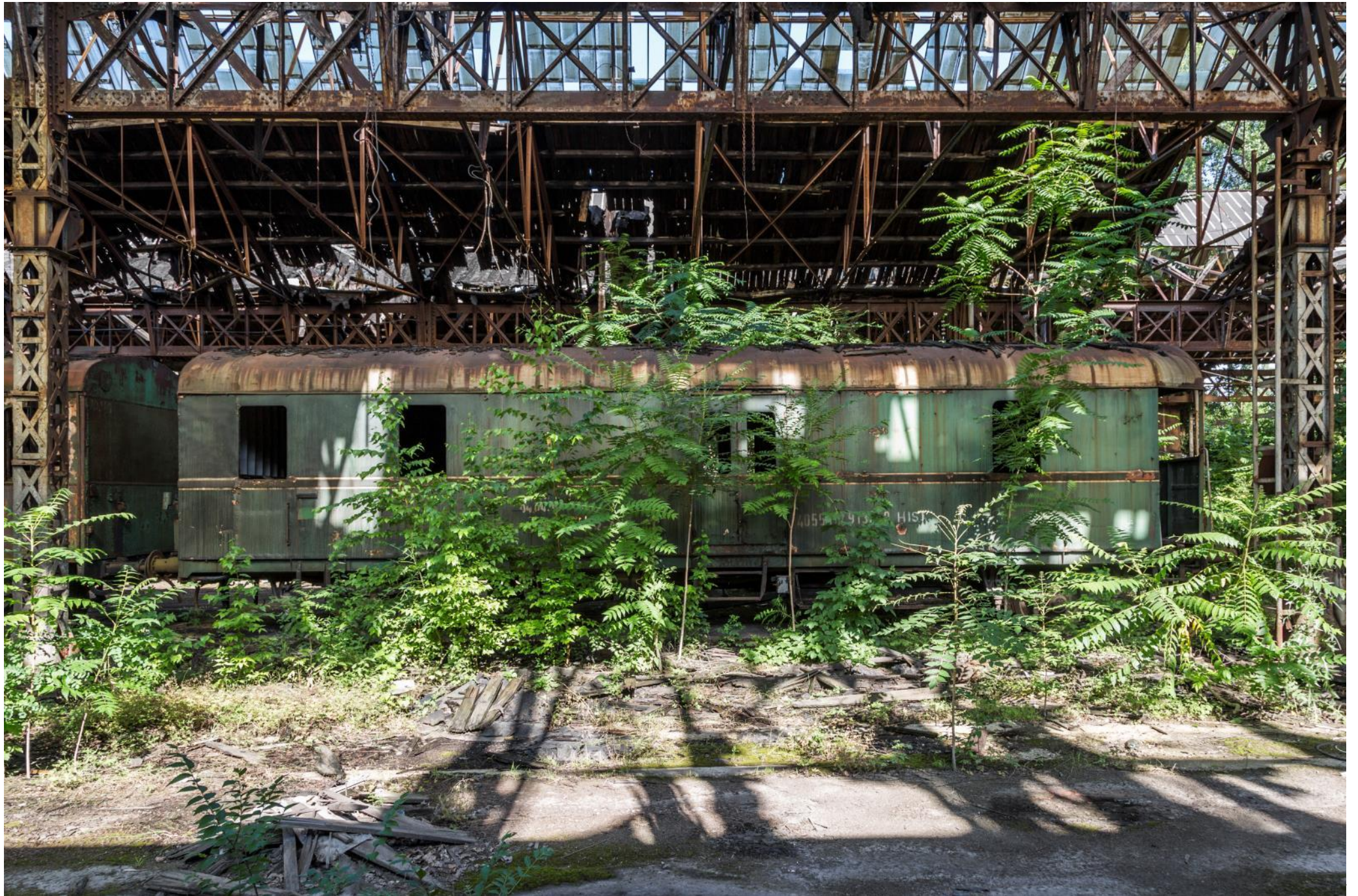
Atelier de réparation de trains, Hongrie
